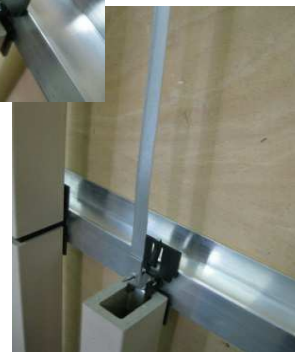
Al-Str. nach vorne biegen, mit nächsten Al-Str. verbinden, nach oben biegen bend Al-stripe forward, connect the next Al-stripe, bend it upwards
