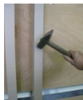
Al-Str. nach vorne biegen, mit nächsten Al-Str. verbinden, nach oben biegen bend Al-stripe forward, connect the next Al-stripe, bend it upwards
