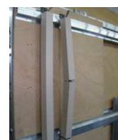
Al-Str. nach vorne biegen, mit nächsten Al-Str. verbinden, nach oben biegen bend Al-stripe forward, connect the next Al-stripe, bend it upwards
