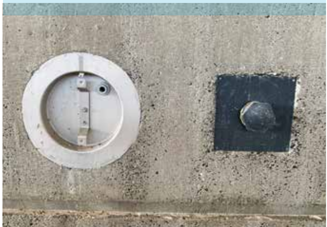
Allasseinän yksityiskohdat ruostumattomasta teräksestä ja PVC:stä.
