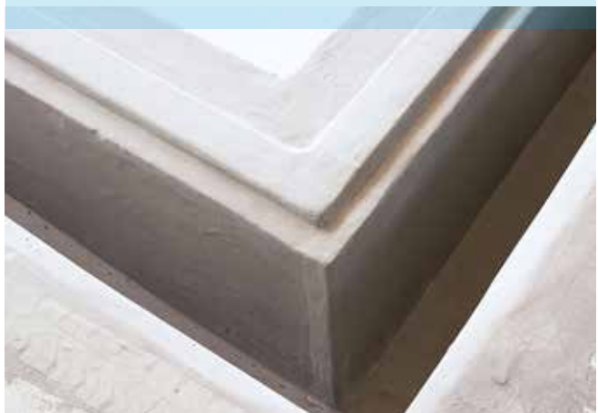
Altaan reunan vedeneristys ja muotoilu.
